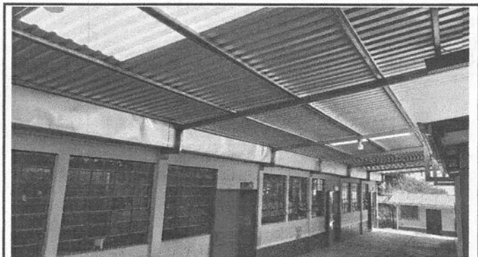
Foto 3: vista del corredor, modulo de trabajo numero 2, con estructura de techo, cubierta de lamina e instalación de canales y bajadas de aguas pluviales instaladas
